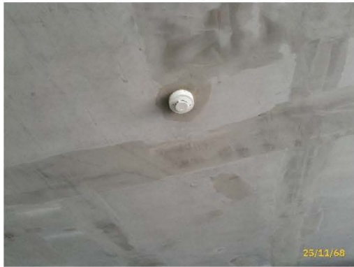
อุปกรณ์ตรวจจับความร้อน/อุปกรณ์ตรวจจับควัน
