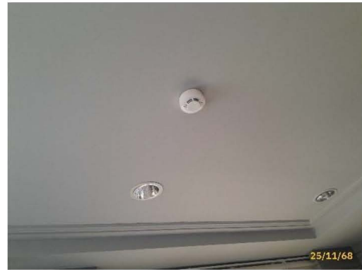
อุปกรณ์ตรวจจับความร้อน/อุปกรณ์ตรวจจับควัน
